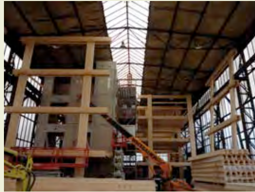
Renovierungsarbeiten in Ludwigsburg
