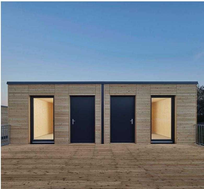
Die Wohneinheiten der aktivhaus Serie 700 können sehr flexibel genutzt und gestaltet werden. Die Module werden im Werk vorgefertigt und vorinstalliert.
