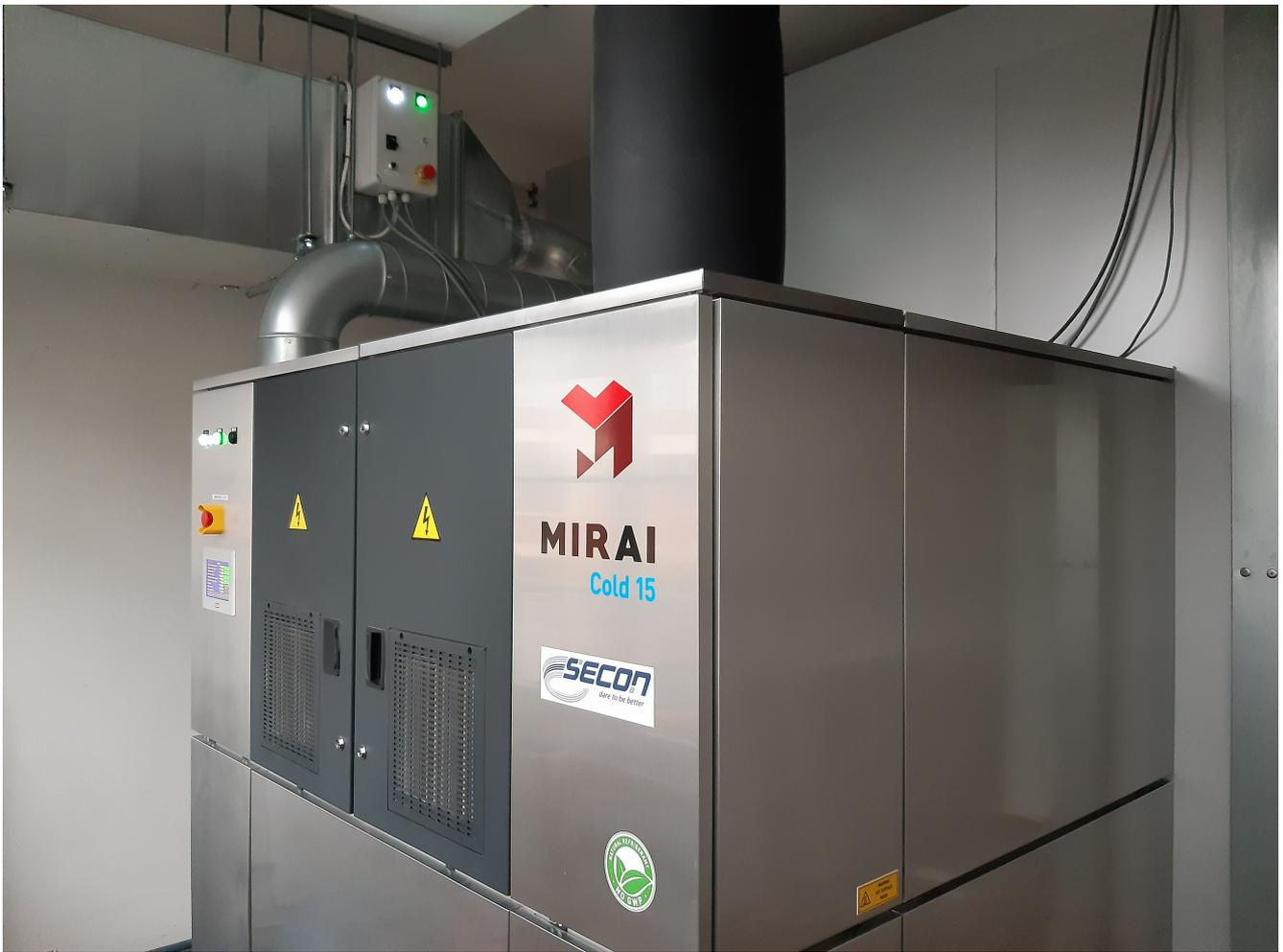
Die verwendete umweltschonende Kälteanlage, deren Technik auf dem Kaltluft-Prinzip basiert
