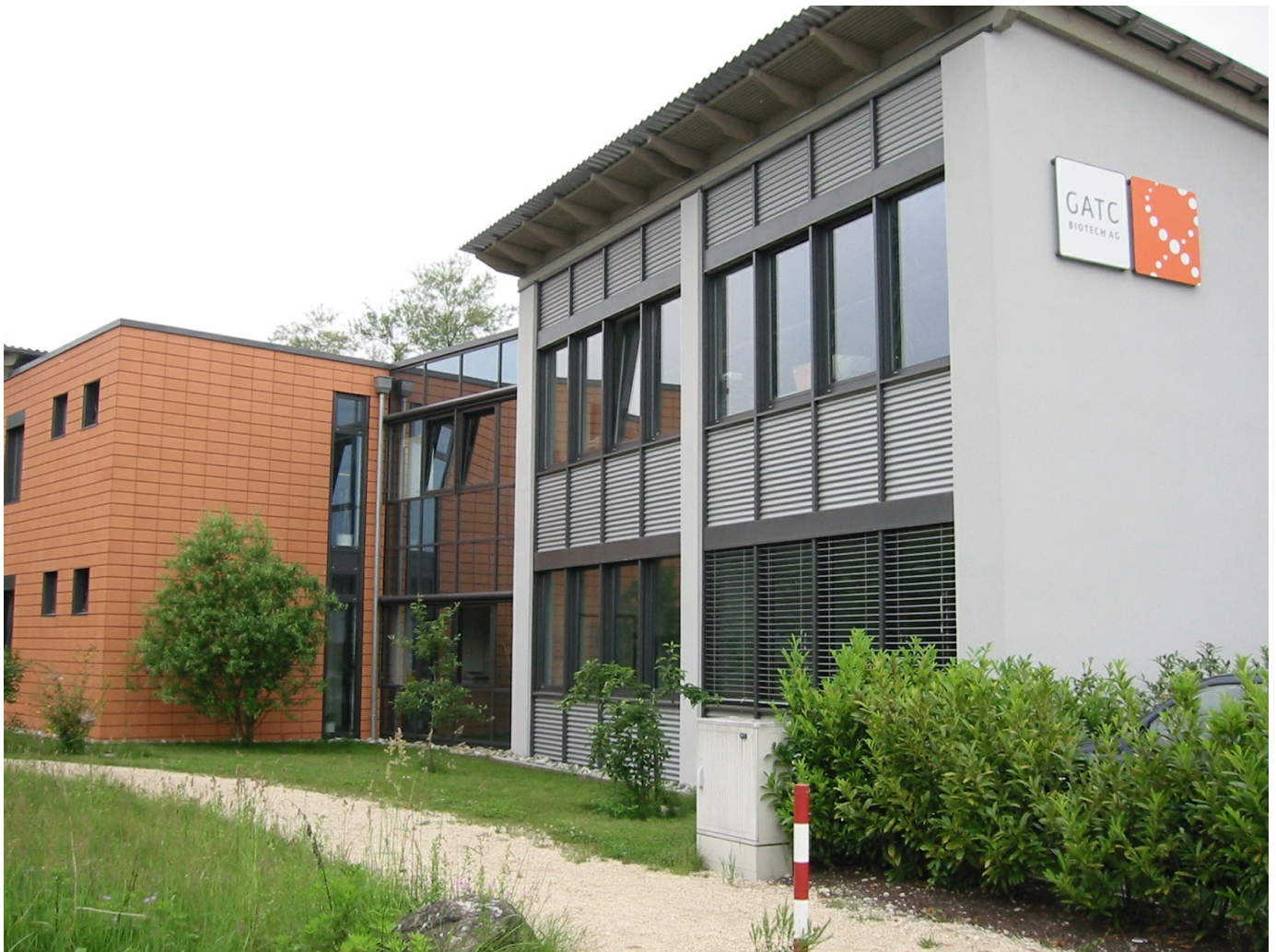
GATC Firmengebäude in Konstanz © GATC Biotech AG
