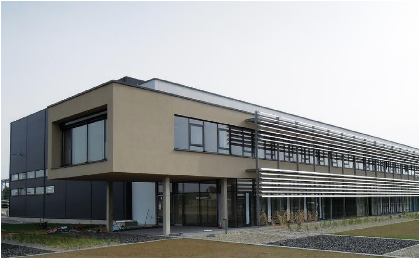
Neubau des Fraunhofer-Zentrums für Chemisch-Biotechnologische Prozesse CBP © Fraunhofer CBP
